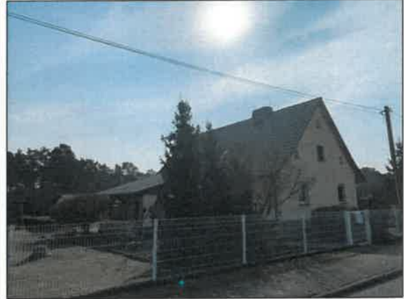
IO-15 Vorwerkstraße 12, Vorwerk
