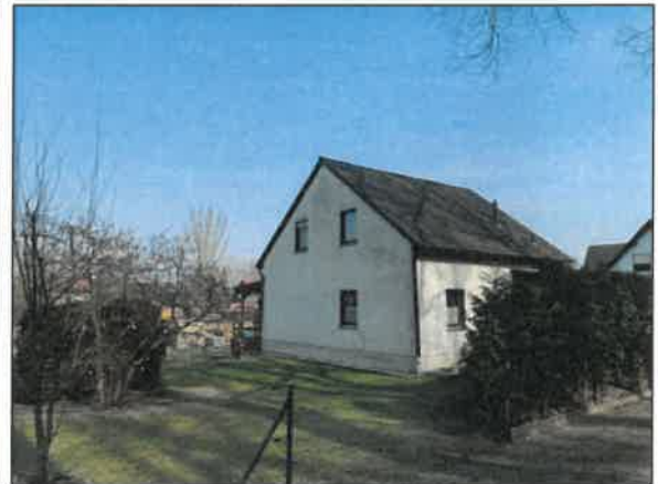
IO-09 Gestütsweg 1, Lübbinchen
