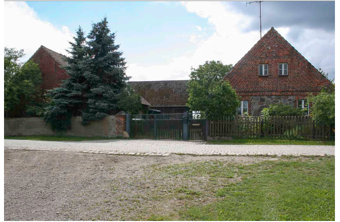
Hof Nr. 14, Wohn- u. Wirtschaftsbau giebelständig, Scheune
