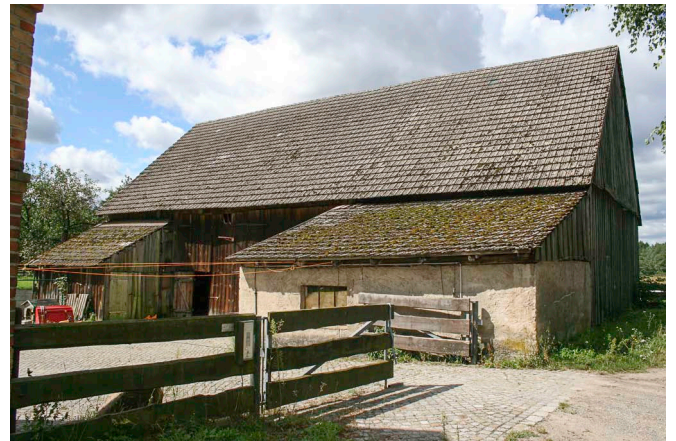
Nr. 2, Scheune mit Anbauten
