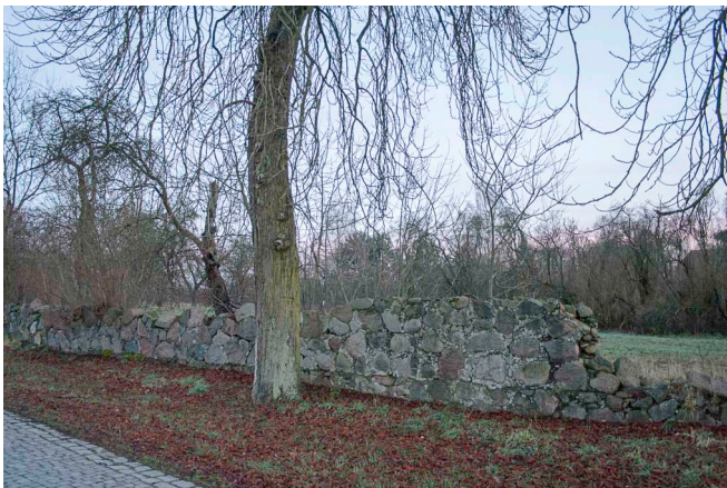
straßenseitige Feldsteinmauer am ehem. Gutsgelände
