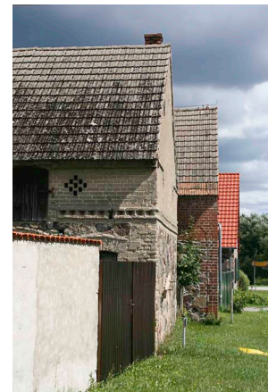
Versetzte Baufuchten Nr. 9 und 10
