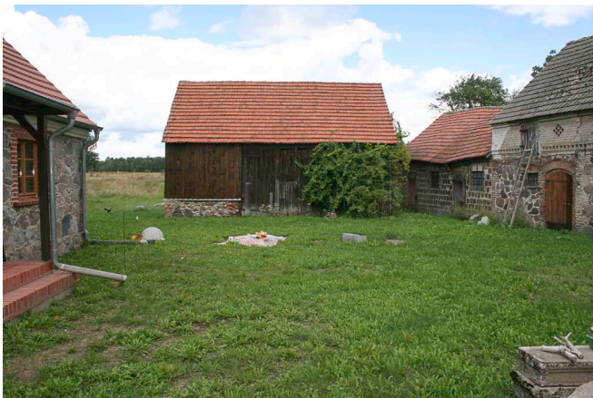
Hof Nr. 9 mit rückwärtiger Scheune
