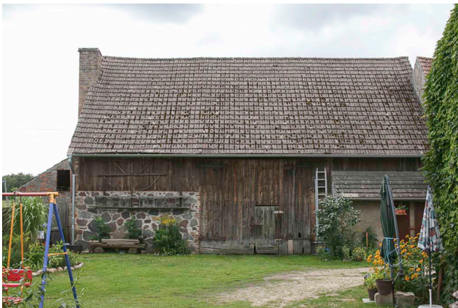
Hofsituation mit Scheune Nr. 15
