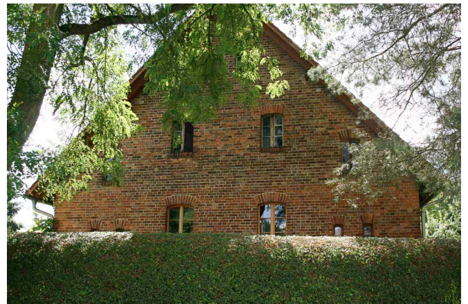
Ehem. Forstarbeiterwohnhaus Nr. 1a, Nordgiebel zur Straße
