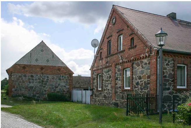
Hof Nr. 13, Wohnhaus giebelständig, Scheune traufständig
