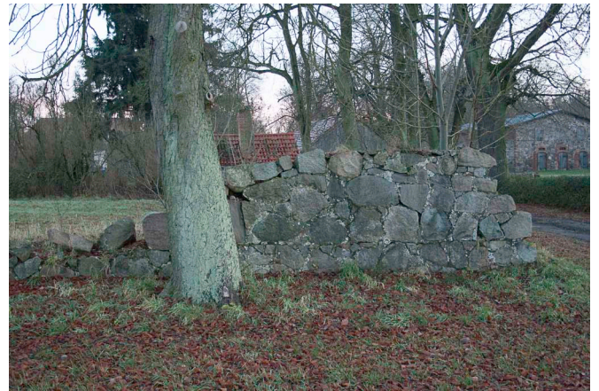
straßenseitige Feldsteinmauer am ehem. Gutsgelände
