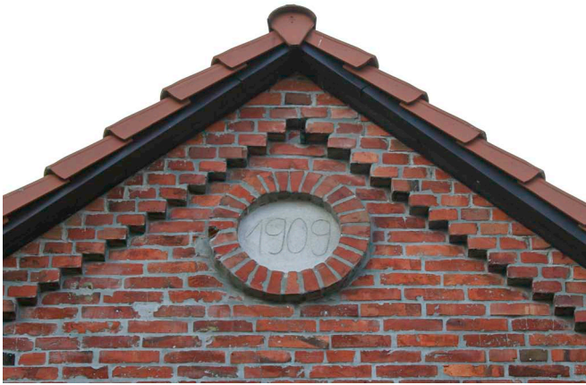
Nr. 16, Giebelblende (erneuert)
