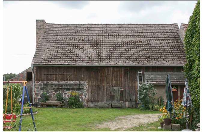
Hofsituation mit Scheune Nr. 15
