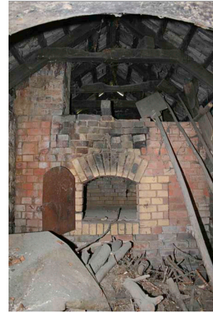
Backhaus am Forstweg
