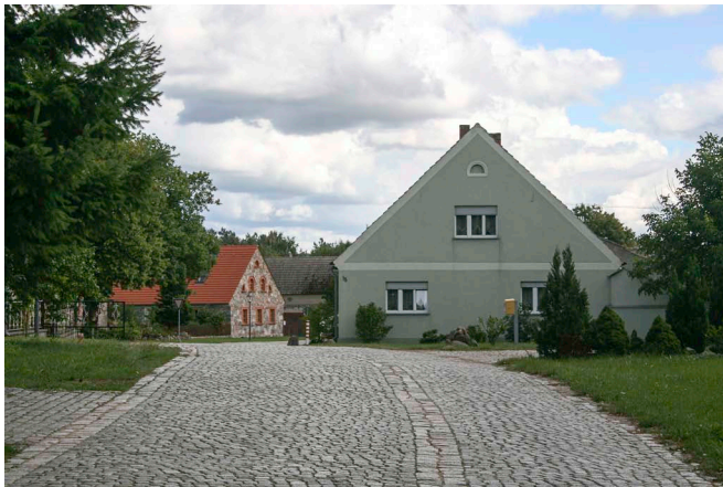
Dorfstraße mit Blick auf Nr. 15 und 9 von West
