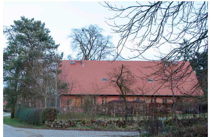
Ehem. Forstarbeiterwohnhaus Nr. 1a von West, Ortseingang
