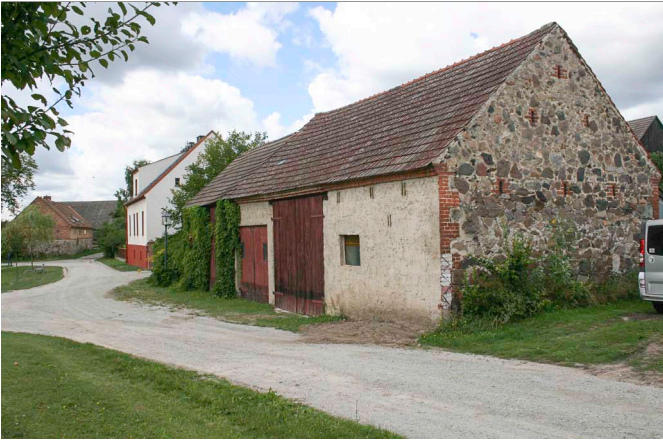
Wirtschaftsgebäude zwischen Nr. 3 und 4
