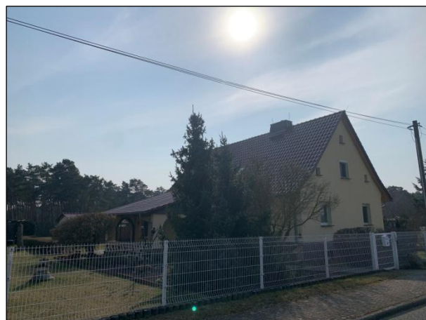
IO-15 Vorwerkstraße 12, Vorwerk
